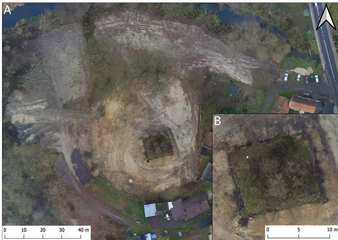
Ryc. 5. Ortoobraz wykonana w 2016 roku na podstawie zdjęć z drona po zniszczeniu stanowiska: ogólny widok (A); zbliżenie na zachowane relikty murowanej wieży (B). Oprac. K. Hanus, G. Kiarszys Fig. 5. Orthoimage taken in 2016 from drone images after the destruction of the site: general view (A); close-up of the surviving relics of the stone tower (B). Developed by K. Hanus and G. Kiarszys
